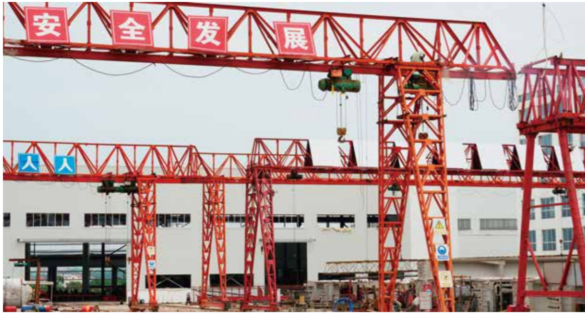
梁板预制场地 Pre-fab Plant
