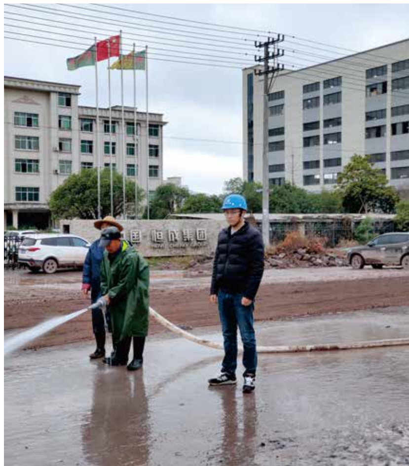
吴涛在检查边通车边施工路段水稳基层冲洗情况
