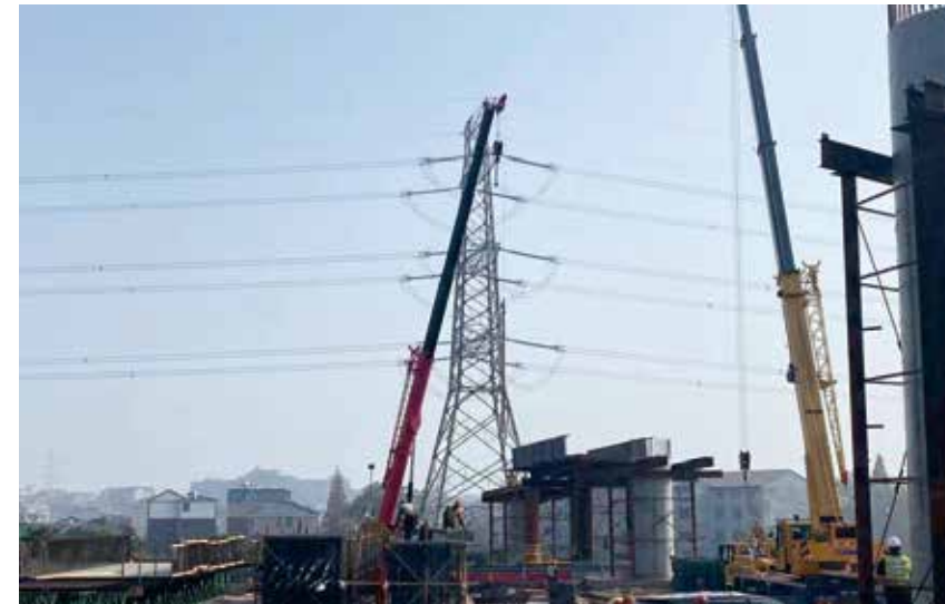
高速匝道封道门式墩盖梁施工平台施工
