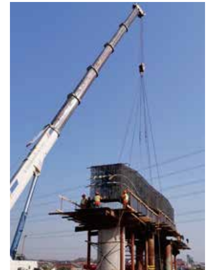
后期门式墩盖梁钢筋骨架吊装
