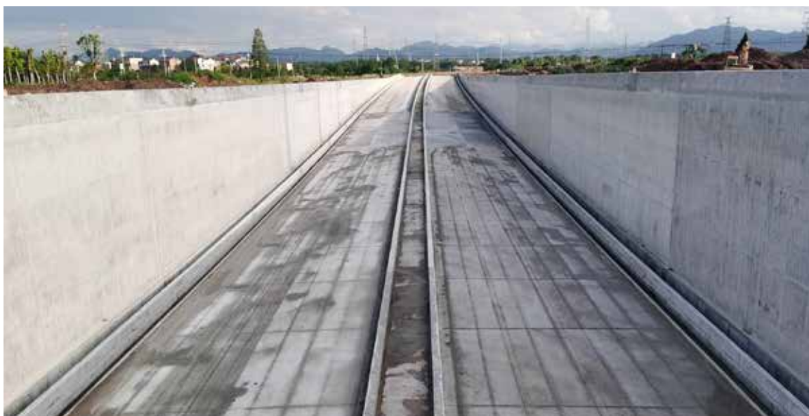
▲ 图为江家互通下穿隧道主体结构南侧第七节路面
