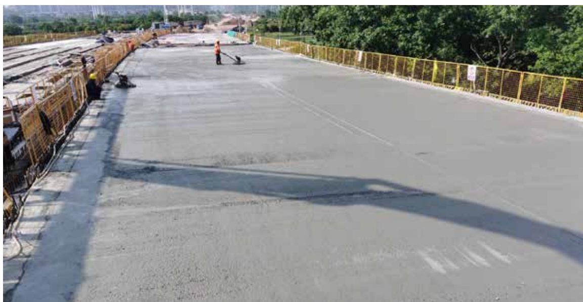
▲ 图为梅溪大桥左幅桥面铺装现场
