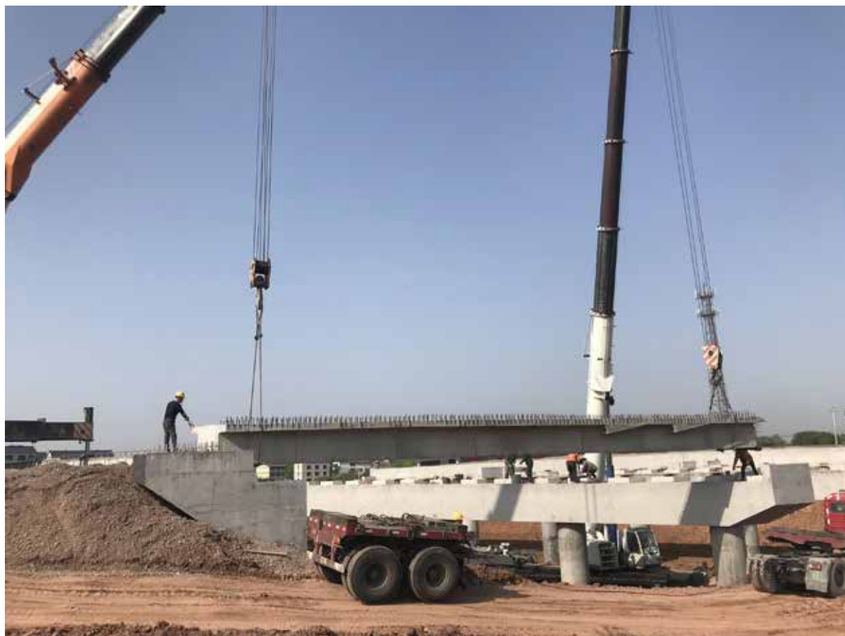
▲ 图为架梁现场
