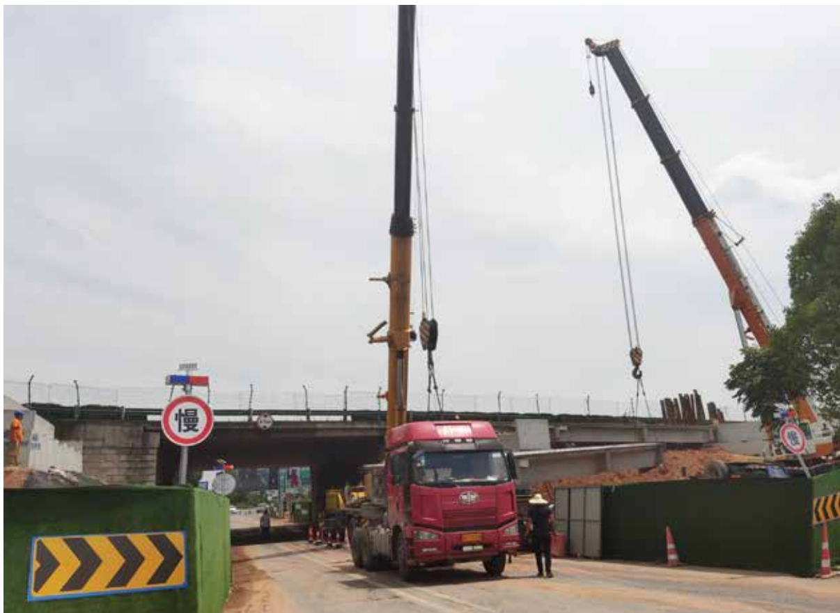
▲ 图为架梁现场
