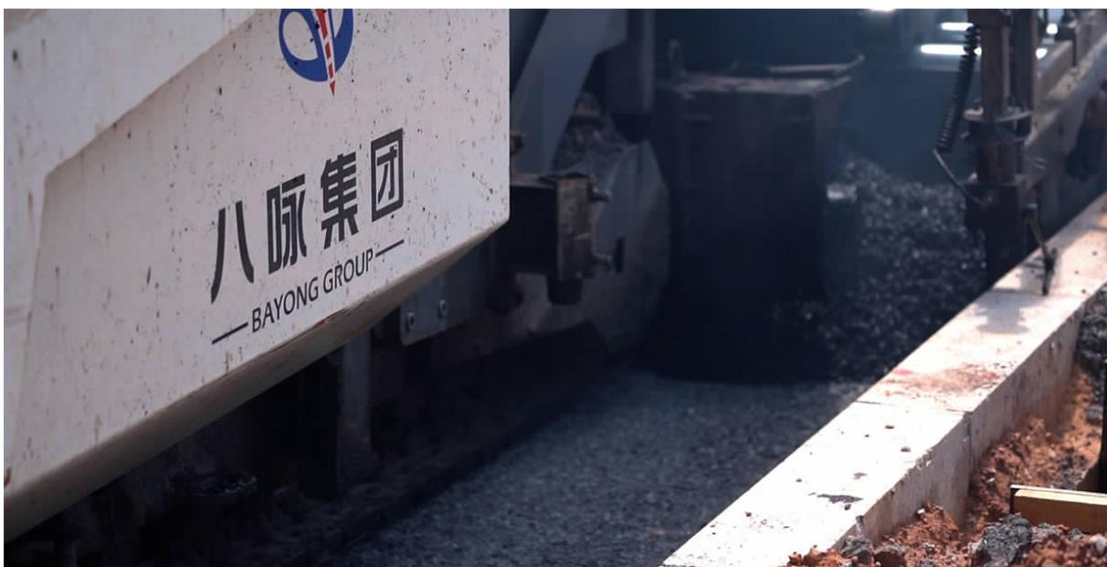
刚出梅,这“三伏”高温天就来了。7月、8月是一年中气温最高的时节,高温环境下有利于沥青混合料施工质量控制,所以也是沥青路面施工的最好时机。上午10点,气温已达到37度,摊铺机下的沥青温度高达160多度。也就是说除了烈日的炙烤,铺路工人还要经受来自沥青高温的“考验”。
